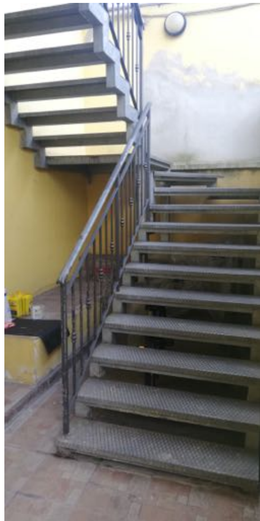
SCALA DI ACCESSO AL BALLATOIO DEL PIANO SECONDO
