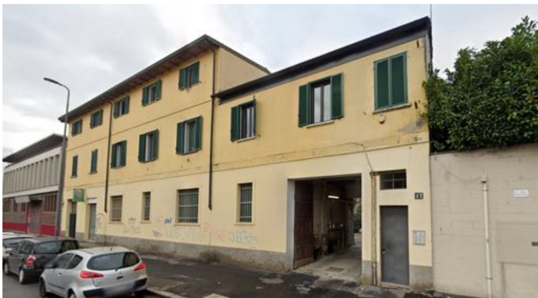
FRONTE EDIFICIO SU VIA PIETRO GAGGIA
